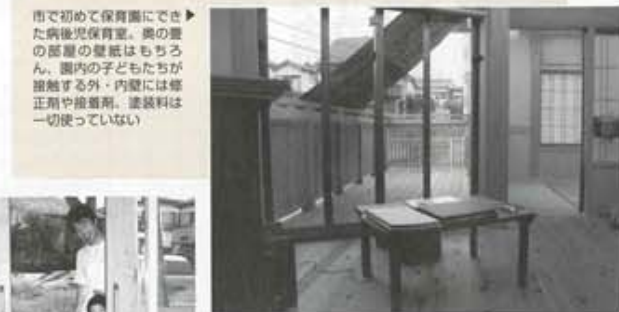
▲2階は子育て支援センター。手動のいすやテーブルは奥園になった幼稚園から譲ってもらったリサイクル品。新しい家具と一緒に使って調和させている。曲線を描いている間伐材には釘も使わず、すべて「組み」で構造材にしている
